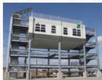
津波避難タワー
