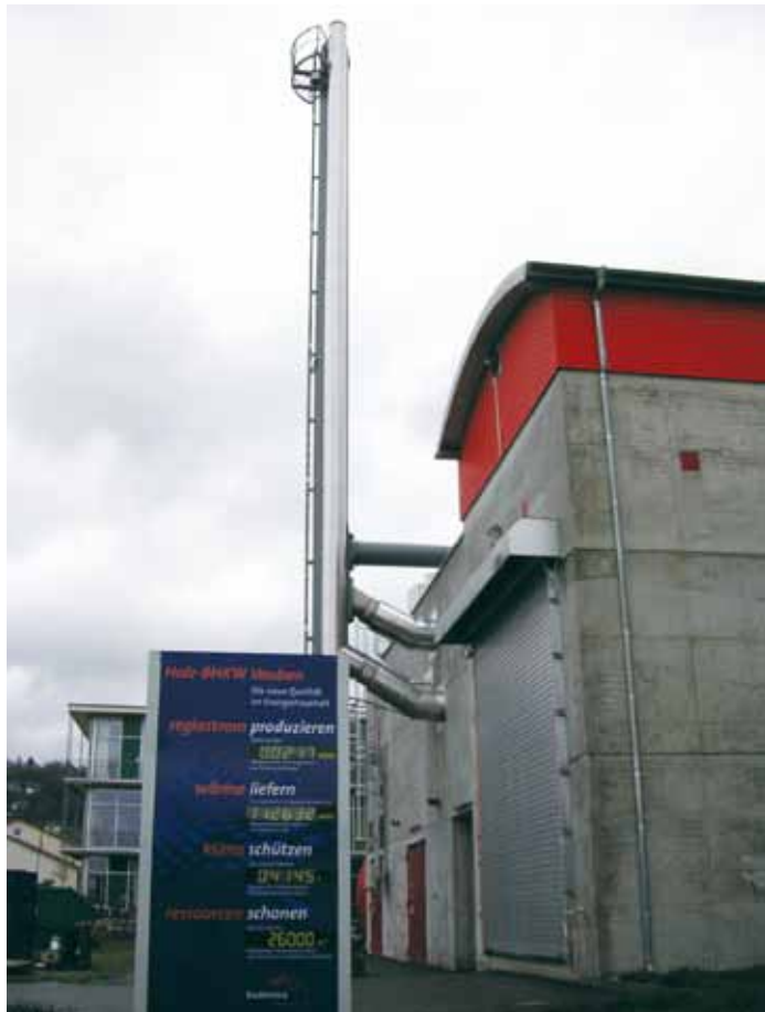
ドイツフライブルク市にある Vauban 住宅地のセントラルヒーティング。
