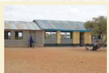
◎UNHCR 修繕された教室。
