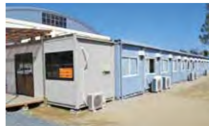
校庭に建つ福浦小学校のユニット校舎
