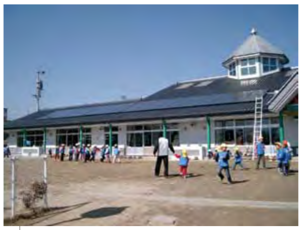
市民出資で設置された幼稚園屋根の太陽光発電所(飯田市)
